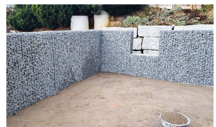
Steinkorbmauer Sonnenrain, Steinerberg
