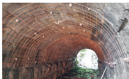
Durchlass Plattenbach, Vitznau
